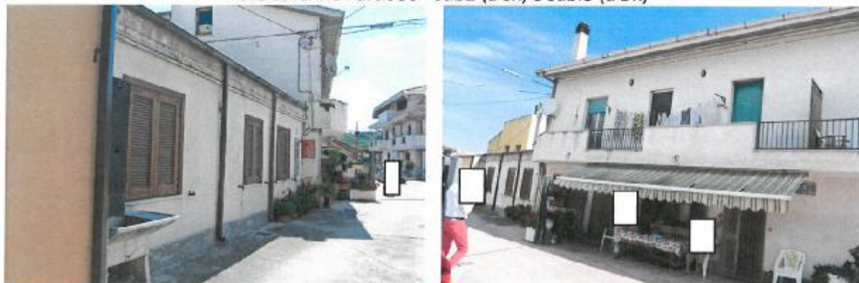
VISTE ESTERNE Part.386 - sub2 (a Sx) e sub.3 (a Dx)
